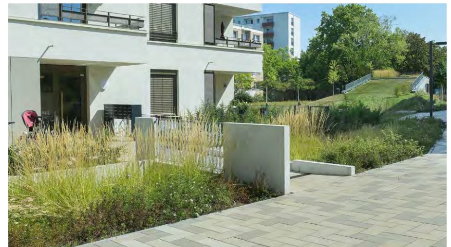
Steg zu Hauseingang über Entwässerungsmulde
