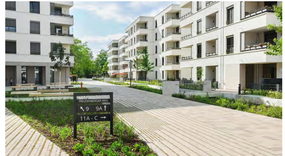
Pflasterbelag mit Grünfugen geht in die Grünflächen über
