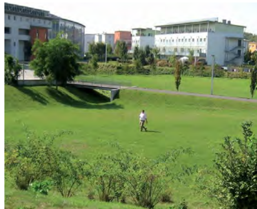
Als Freiflächen genutzte Retentions- bzw. Versickerungsmulden
