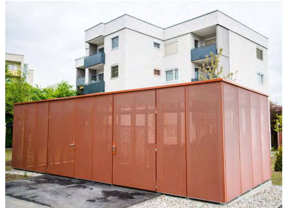
Infrastrukturbox in der Edisonstraße Credits: Innovametall
