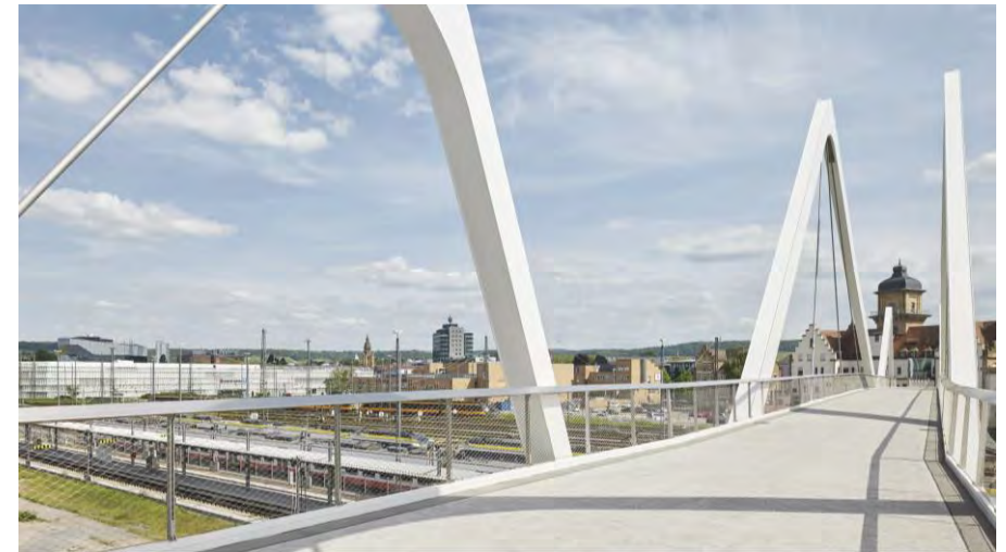
BUGA-Brücke über den Gleisen
